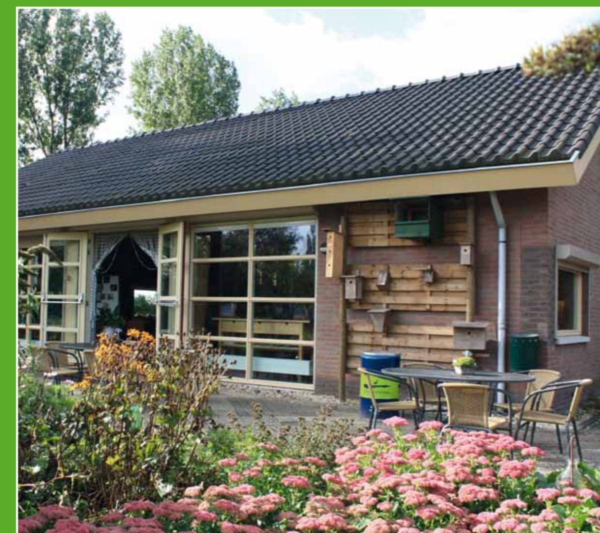
④ Streekcentrum Alblasterwaard
